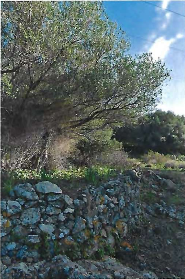
Les terrasses de cultures ne sont plus cultivées et servent aujourd'hui de zone de pâturage aux ovins. La topographie, sur les zones les moins abruptes, ont permis aux murs de soutènement historiques en pierres sèches de se maintenir.
