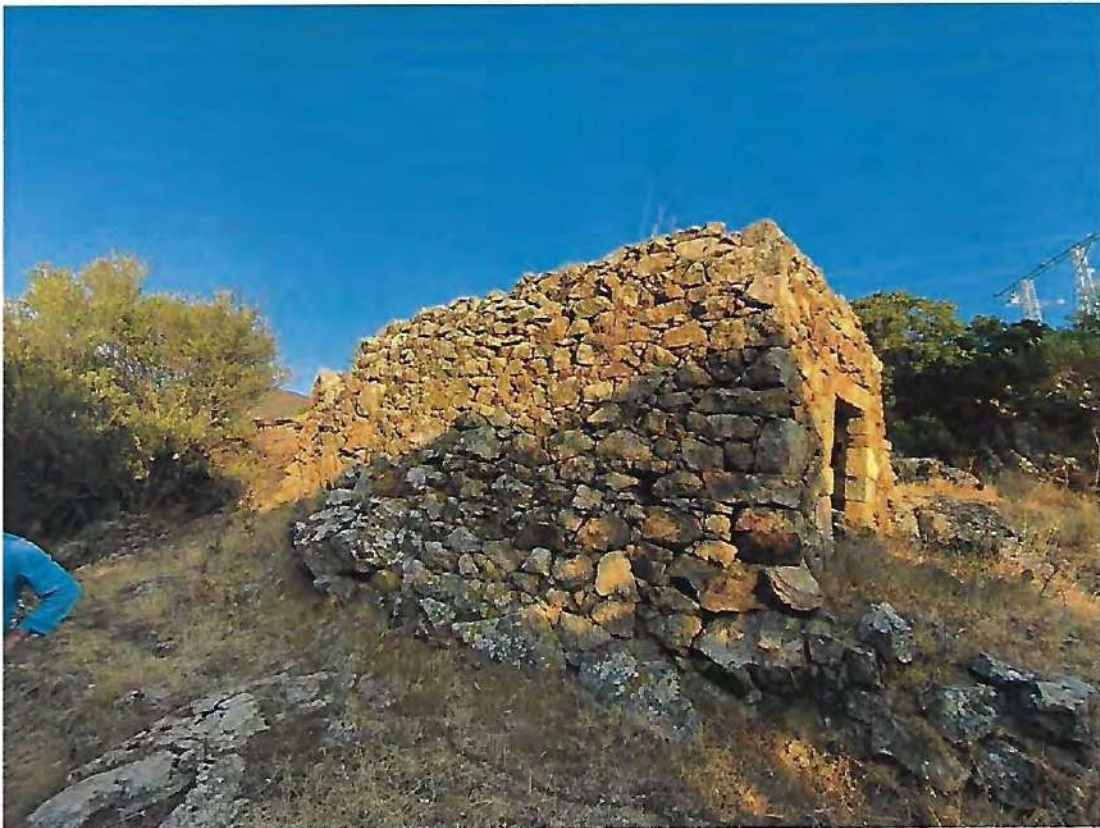
Parcelle 331. Détails de la construction rurale : emmarchement, porte principale (notons que le jambage ne comprend pas de clé horizontale qui caractérise souvent les entrées des logements dans le village) et enclos maçonné attenant.
