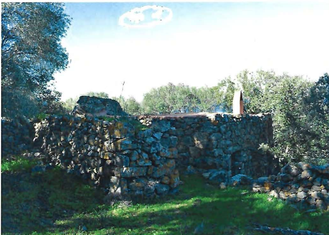
Ci-dessus, vue du bâti rural de la parcelle 224
