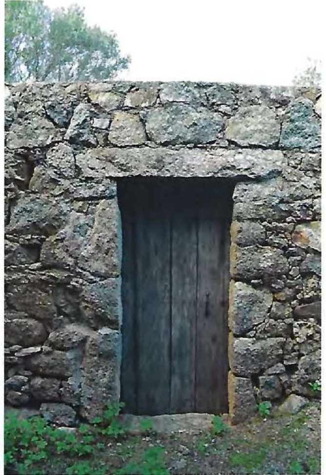
Parcelle 331. Détails de la construction rurale : emmarchement, porte principale (notons que le jambage ne comprend pas de clé horizontale qui caractérise souvent les entrées des logements dans le village) et enclos maçonné attenant.
