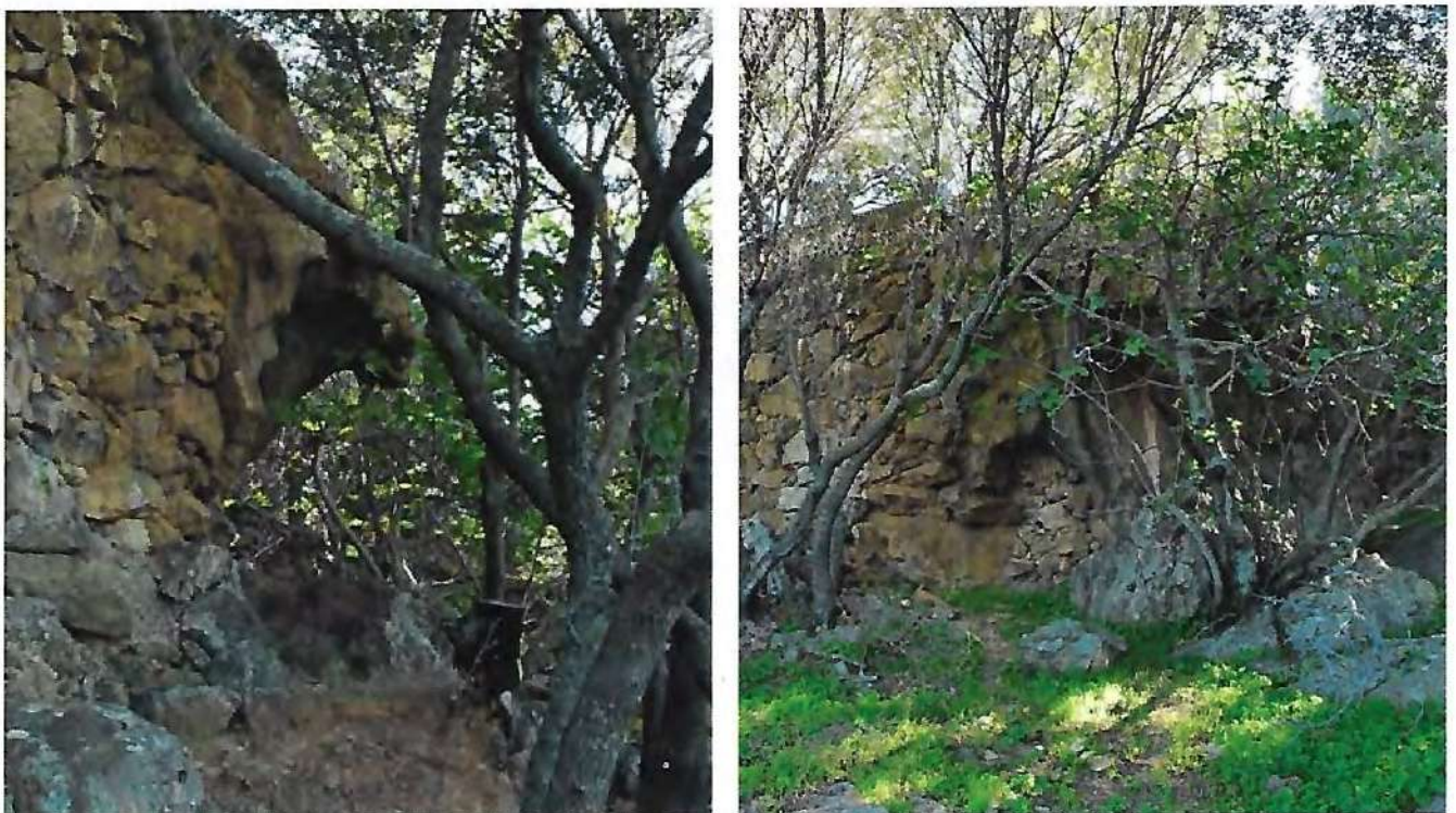
Détail du bâti rural parcelle 223, construit sur un probable ancien abri sous-rocher (repéré d'un cercle rouge sur le plan)
