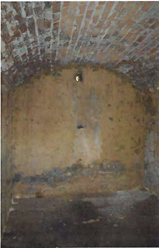
Aperçu de l'état intérieur : la voûte en briques est en anse de panier.
